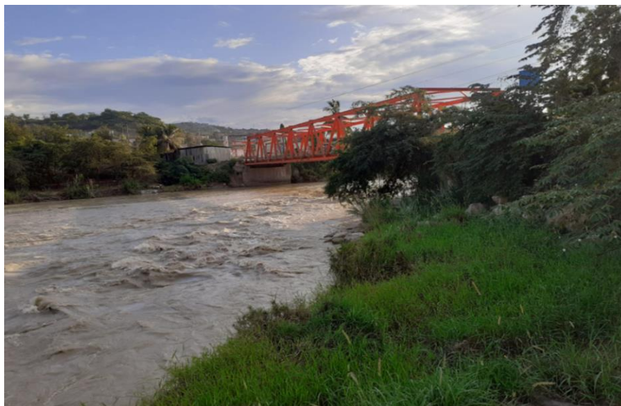
FIGURA N°01: : TRAMO CRÍTICO EN EL PUENTE CAJARURO PRESENTADO EROSION EN LA MARGEN DERECHA DEL RIO UTCUBAMBA EN EL SECTOR PUENTE CAJARURO, DISTRITO DE BAGUA GRANDE, PROVINCIA UTCUBAMBA - AMAZONAS.
